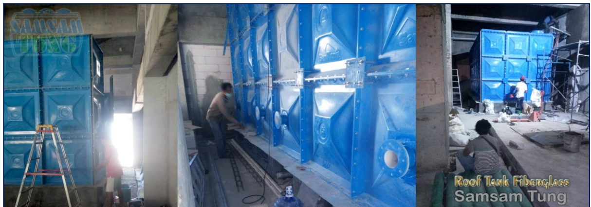
Gambar suasana pemasangan Roof Tank di Proyek
